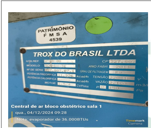
Evaporadora sala 1 bloco OBS
