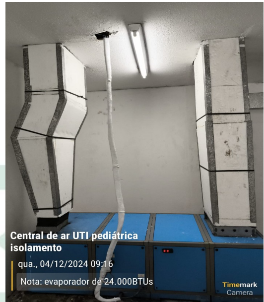
Evaporador isolamento PED
